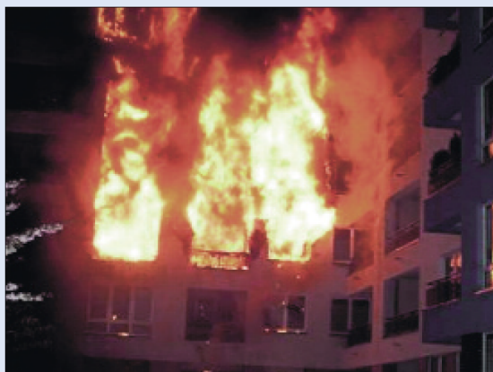
Bei diesem Brand einer mit Hartschaum gedämmten Fassade in Berlin waren insgesamt 13 Fensteröffnungen betroffen (Quelle: Feuerwehr Berlin)
