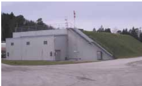
Erdgedeckter Lagerbehälter als sog. Hünengrab ausgeführt
