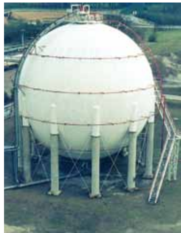
Kugelgasbehälter 3 000 m 3 (heutzutage eine Seltenheit)
