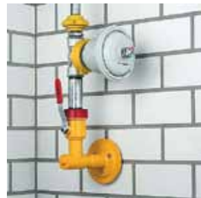
Bild 6: HAE innerhalb des Gebäudes
