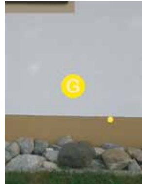
Bild 5: Kennzeichnung der Einführungsstelle der Hausanschlussleitung
