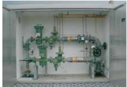
Bild 3: Gas-Druckregel- und Messanlage in Schrankgröße außen und innen
